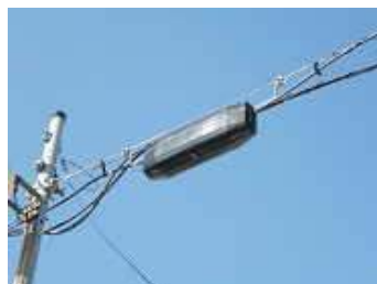
架空クロージャ (施工後)
