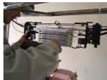
ドロップケーブル融着作業
