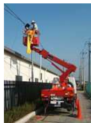
光ケーブル架空敷設作業
