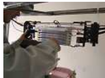
ドロップケーブル融着作業
