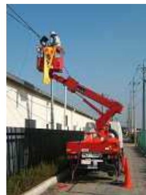
光ケーブル架空敷設作業
