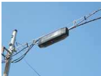
架空クロージャ (施工後)
